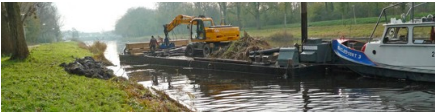
Bij werk in het park informeert de Damesbende van Buiksloot altijd even waar het voor is. Ze herinneren zich nog al te goed hoe zij op een vroege ochtend in het voorjaar kap moesten tegenhouden. Op de foto wordt de beschoeiing van het kanaal gerepareerd op de plek van de lage brug.
