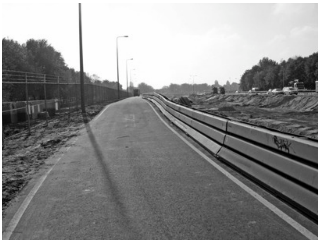
De noodweg naar het benzinstation. Dit wordt het fietspad. Links het hek om Volewijkspark oost, rechts wordt de NLW uitgegraven. In de verte naast de auto een ambtenaar die onderzoekt of het fietspad nu al in gebruik genomen kan worden. Het is een aardig doel voor een zondagmiddagwandeling. U kunt er komen via de Texelweg en zien hoe het fietspad langs de NLW komt te lopen, en hoe hoog (3,5m +NAP).
